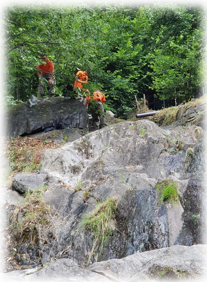
Sotto: Arbedo - Militi al lavoro sul greto del riale.
